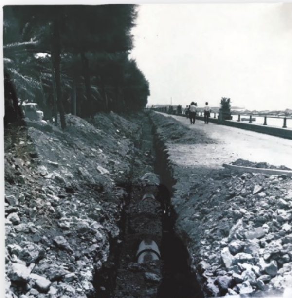
N.19 - Grande anello distribuzione zona occidentale di Salerno 1° tronco - Tratto di condotta seminterrata pronta per la prova.
